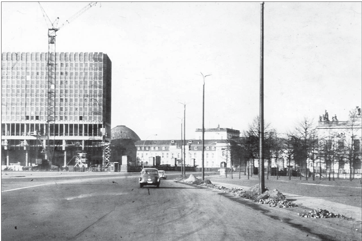
Abb. 9: Beeinträchtigung der Sichtbarkeit alter Gebäude des historischen Berlins durch den Neubau des Außenministeriums.
