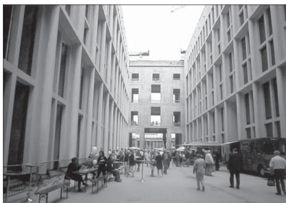
Abb. 15: Neue Passage durch das Schlossgebäude: zwischen Portal II und Portal IV – im Rohbau, 2016
